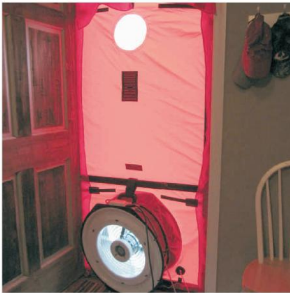
Door opening exhaust fan
